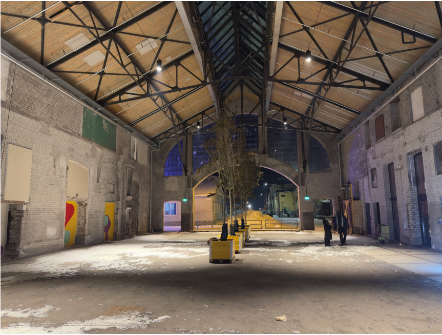
Figur 2. Förbindelsehallen mellan slakt- och kylutrymmen.
